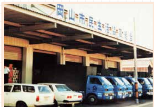
▲配送センター(現在の東岡山センター)が完成(1979年4月)
