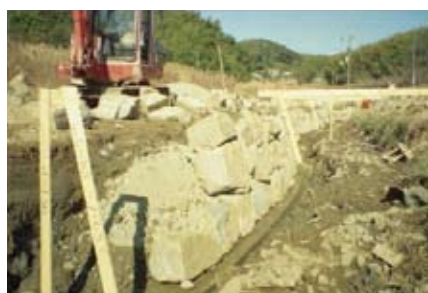
1995年2月3日 護岸改修中既存水路底と対岸は残した
