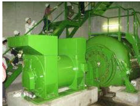
↑ 8/21 梶並発電所内（岡山県企業局）
