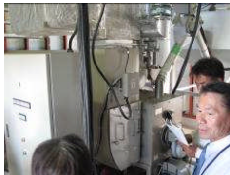
↑ 8/21 美春閣ペレットボイラー内部見学
