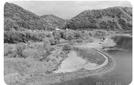
せき止め→の様子
