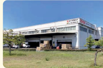
岡山冷蔵流通センター(岡山市南区藤田)
