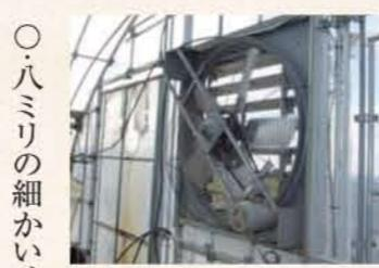
暑くなりすぎないよう、二五度を超えると、ハウスに取り付けてある換気扇が自動的に回り始めます。また、ハウスのビニールを一枚めくると、
