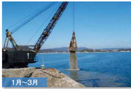
1月～3月 底質改良 カキ殻を海底に敷き詰めて海底の土の質を改良。
