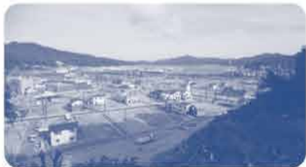
岩手県大槌町中心部の様子。 建物が建ちはじめ、線路の復旧工事も 始まりました。(2017年9月)
