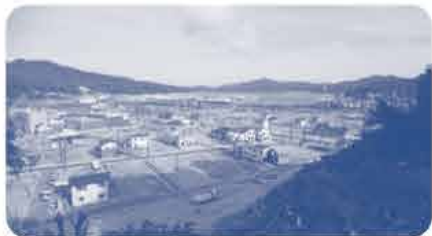
岩手県大槌町中心部の様子。 建物が建ちはじめ、線路の復旧工事も 始まりました。(2017年9月)
