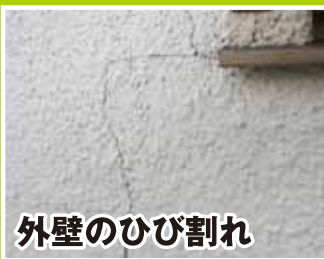
壁面塗装の劣化
